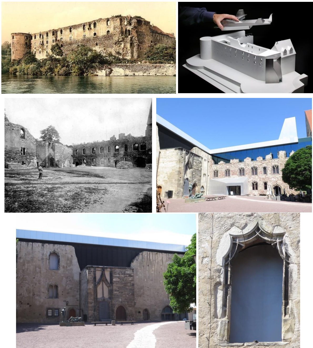
Figura 9 – Kunstmuseum Moritzburg Halle : a ruína como pano de fundo para o projeto autorreferente e ofensivo aos elementos originais ainda remanescentes. E a lacuna transformada em figura pelo não restabelecimento da unidade potencial ainda existente.
