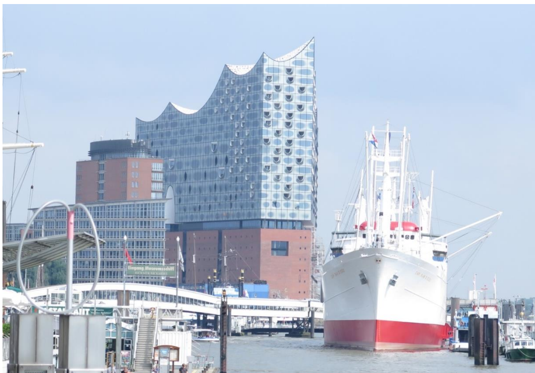
Figura 5 – Elbphilharmonie , Hamburg, Herzog & de Meuron, construída sobre o edifício moderno, do qual foi parcialmente preservado somente a caixa mural, aumentada em 2m de altura. Internamente o edifício foi totalmente destruído Fonte: Foto Betânia Brendle, 2016.
